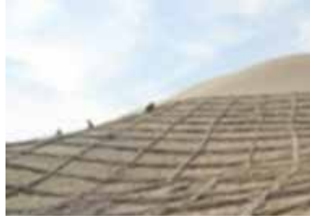
الشكل 16- تثبيت الكثبان الرملية في صحراء كوبوكي في شمال الصين
